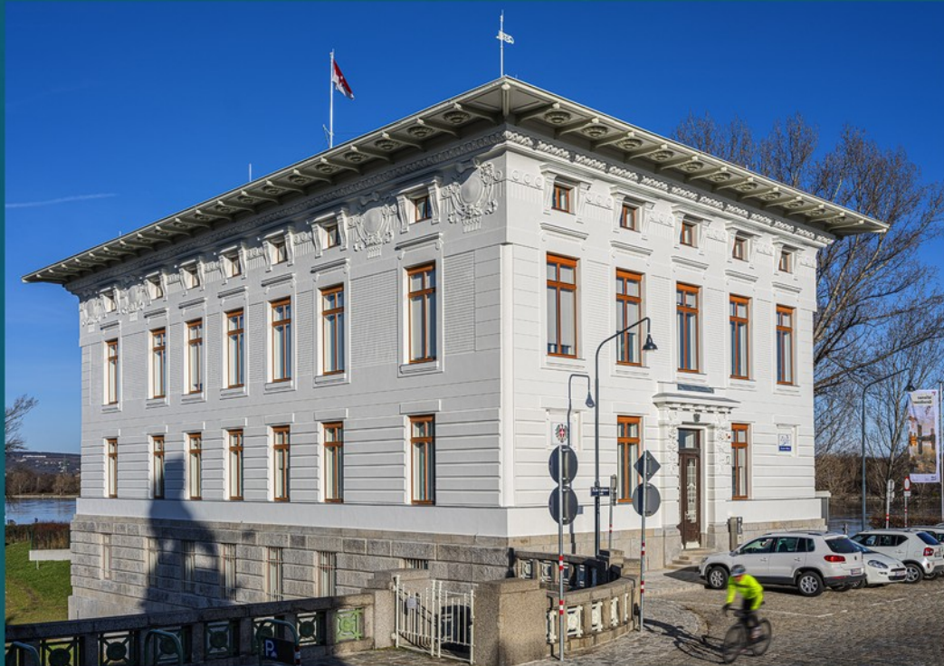
Fensterteilung nach Sanierung
