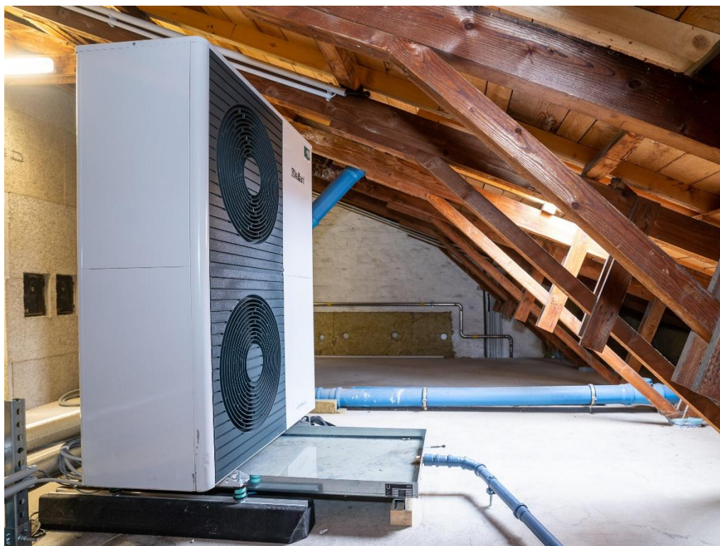
Luftwärmepumpe im Dachraum Quelle Sozialbau AG
