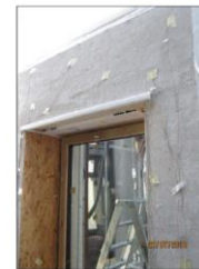
Figure 3: Montaggio serramenti lato caldo.
