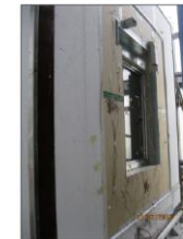
Figure 1: Montaggio serramenti lato freddo.
